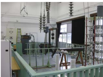
高電圧実験室
