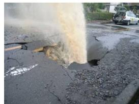
図 1 水道管破裂例
