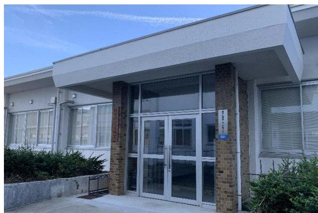
産学民連携リサーチセンター
