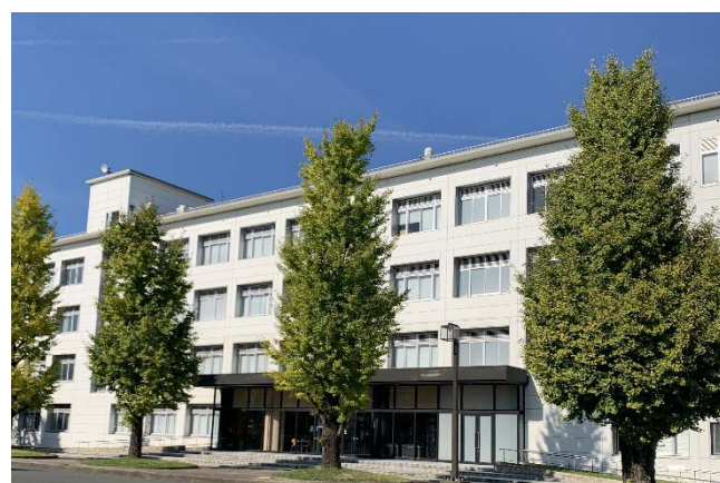
機械・材料システム工学科棟
