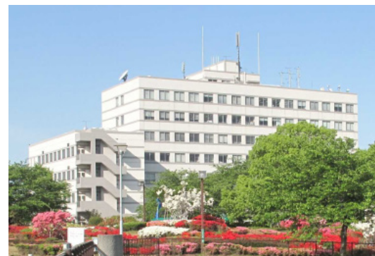
株式会社久留米リサーチ・パーク
