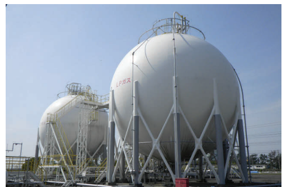
LPガスプラント
