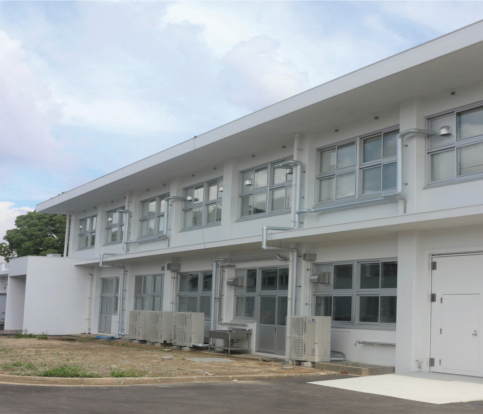
(写真) 熱材力実験棟 (改修後)
