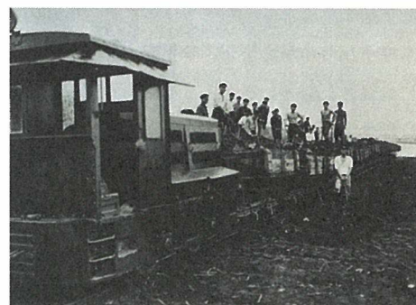
トロッコを引いて運動場の整備（昭和15年）
